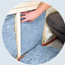
增加絕緣材料和修復漏氣的地方
